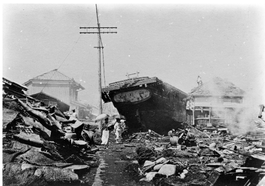
図1 津波によって伊東の県道に運ばれた漁船。(上)油絵、(下)写真。
