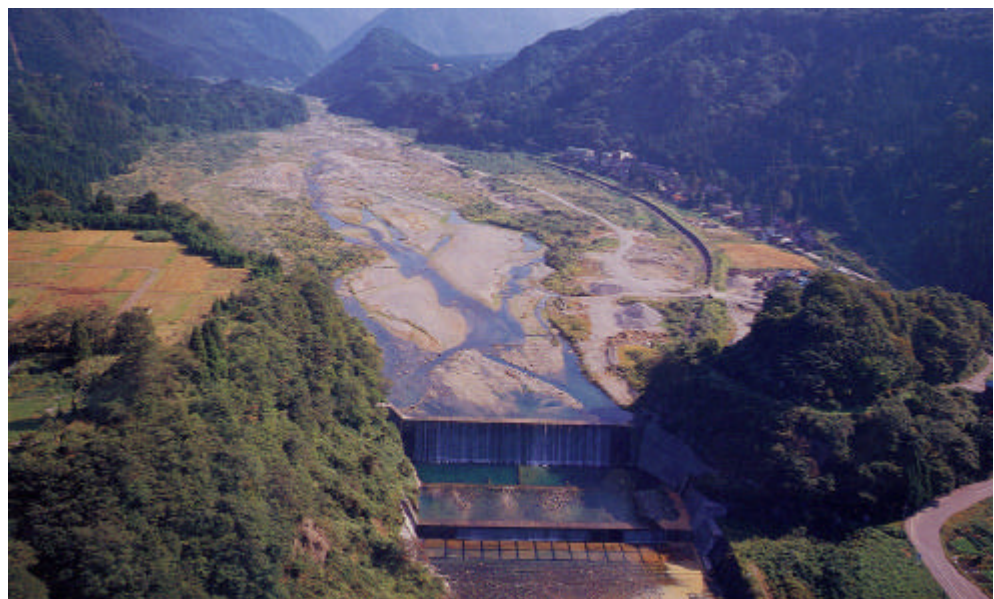
本宮砂防ダム(立山砂防工事事務所)
