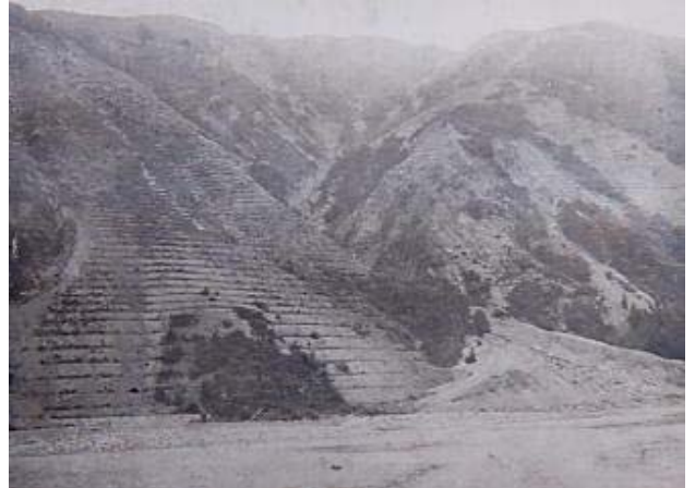
根尾谷之部第二号 本巢郡中根尾村大字板所崩壊
