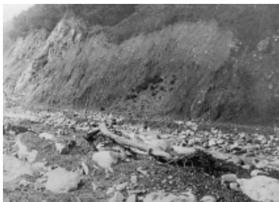
北山谷之部第三号 揖斐郡坂内村大字川上字墨俣崩壊
