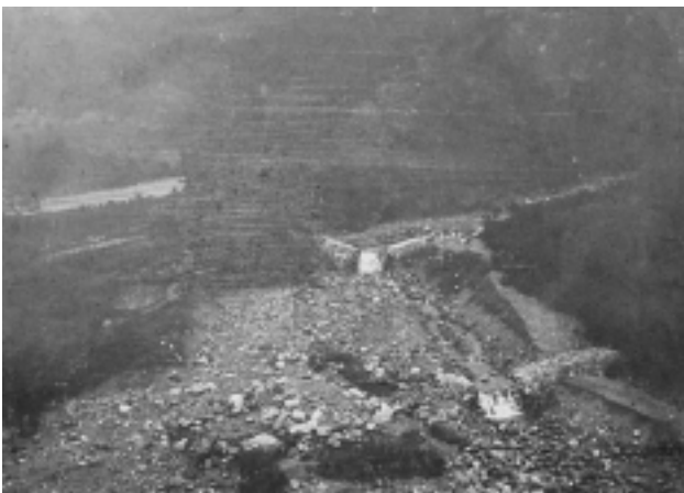
根尾谷之部第一号 本巢郡外山村大字金原地内金原谷崩壊
