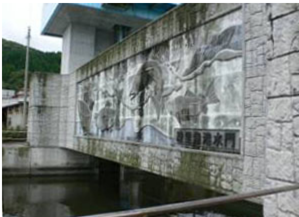
写真4 綾里漁港の水門
