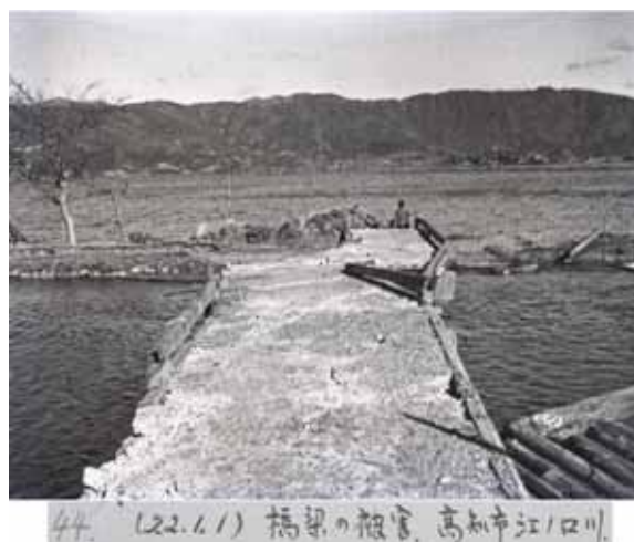
図 5 弥右衛門堤防の決壊被害 (上、高知市所蔵) と江ノ口川の橋梁の被害 (下、沢村武雄氏撮影、高知大学理学部附属地震観測所提供)
