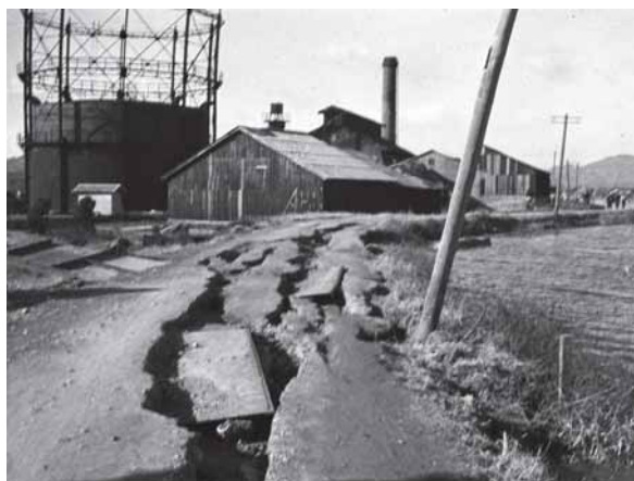
45. 地盤沈下で道路の亀裂. 高知市下知. ガス会社付近. 右は江ノ口川 (22.6.1)
