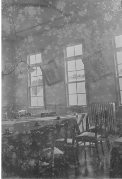
図5 本館2階会議室東側の壁
