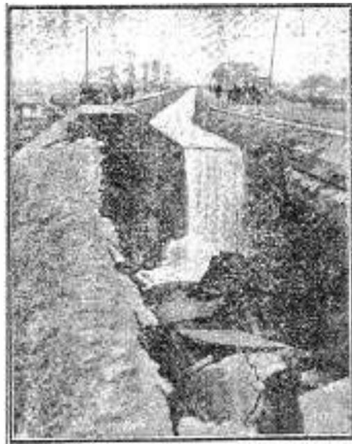
図 2 1921 年龍ヶ崎付近の地震による新水路の被害の様子(場所: 第一ずい道付近)
