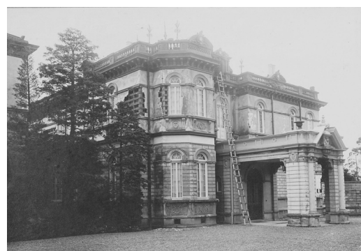
写真-8 洋館正面
