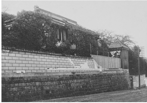
写真-9 外構煉瓦塀
