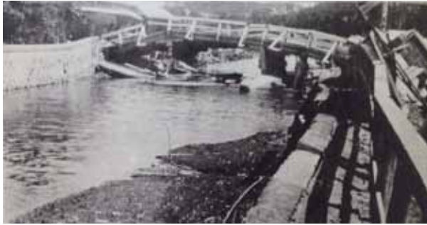
図2 逗子田越橋の損壊状況(西坂,1926)。手前右端に見える手すりの影が画面左に向かって伸びていることから、画面右側が南と考えられる。従ってこの写真は下流左岸から上流にカメラを向けて撮影されたと考えられる。
